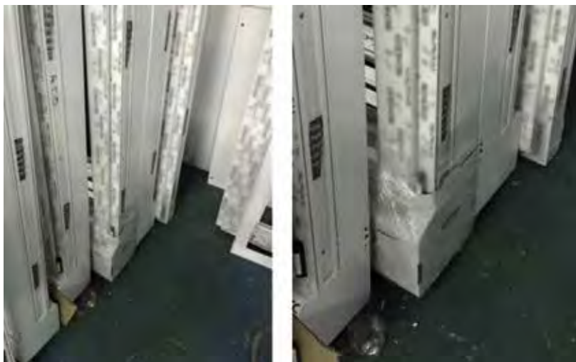
Figura 66. Detalle de ventana con cajón almacenada con el cajón hacia abajo, y embalada, en general, se desaconseja esta posición para almacenar el conjunto ventana+cajón
