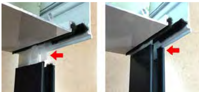
Figura 59. Unión ventana cajón
