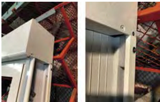
Figura 60. Embudo introducido en guía, con atornillado lateral
