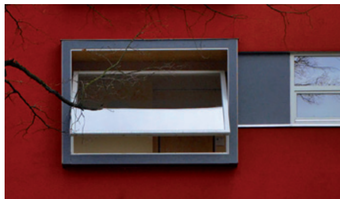
Ventana basculante para pesos de hoja de hasta 300 kg
