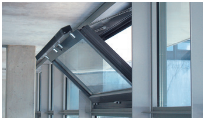
Los accionamientos por cadena dosifican perfectamente la ventilación de estancias con grandes anchuras de apertura de hasta 750 mm
